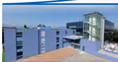
ROVER - Ingresso uffici e laboratori
