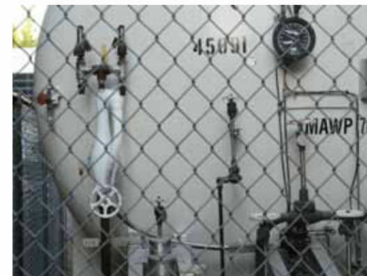
Molti siti da ispezionare sono difficili per alcuni sistemi di messa a fuoco automatica
