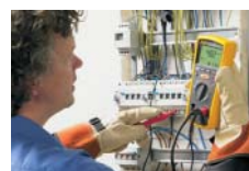
Test d'isolamento su un quadro di distribuzione
