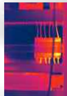
Immagine termica 1 ad alta risoluzione
